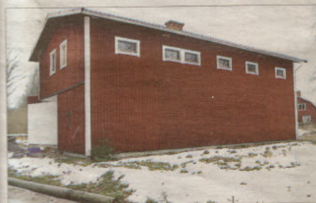
Mot söder finns 18 kvadratmeter fönster. Men mot norr är huset helt slutet, av energiskäl.
